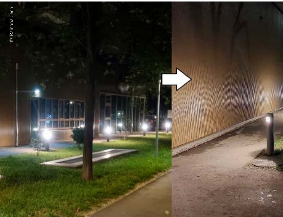
Nach der Beratung der WUA: Umstellung auf eine umweltfreundliche Außenbeleuchtung
